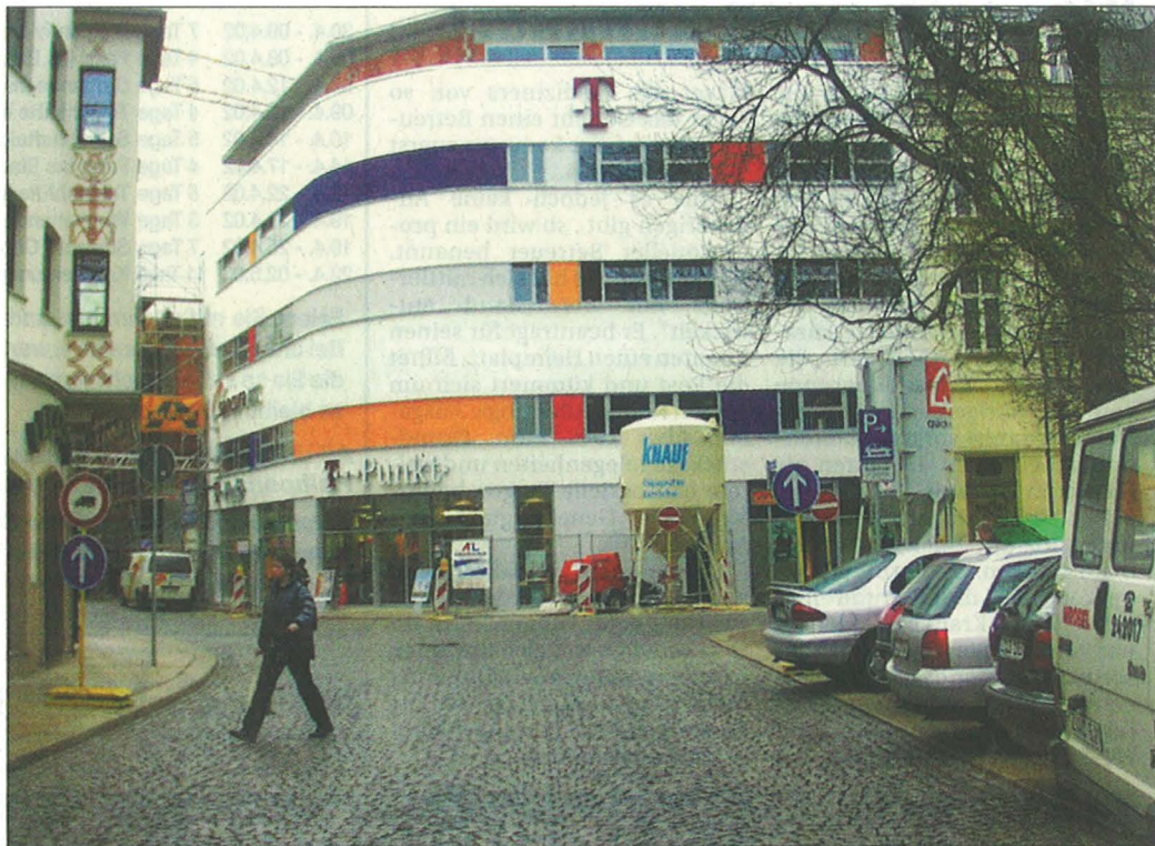
Die Hüllen an der Ecke Penzler-Magazinstraße sind gefallen. Ob die Ansicht gefällt ist noch strittig.
