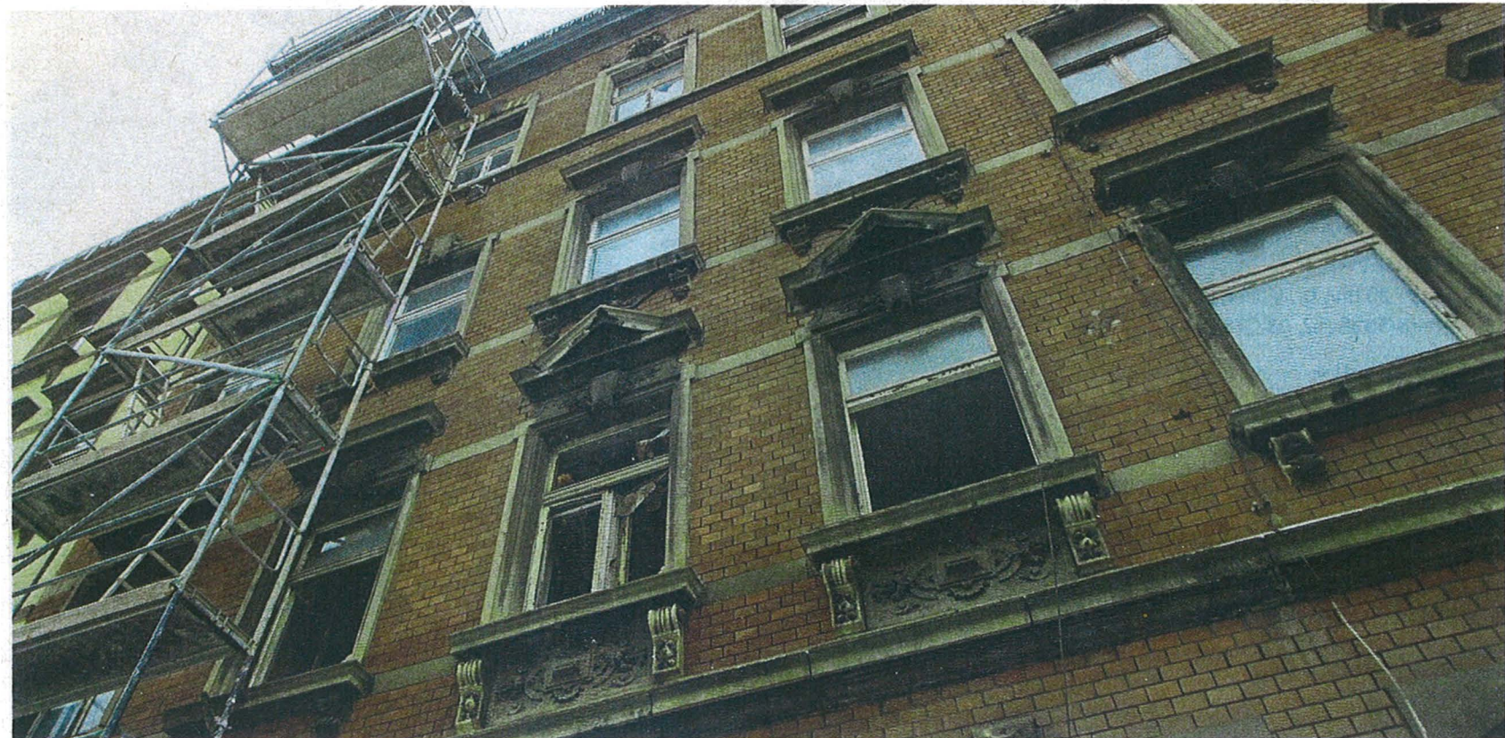
Das Haus Leipziger Straße 82 soll abgerissen werden. Ab Montag ist die Straße deswegen gesperrt.
